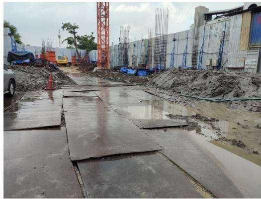
4-10 ปูแผ่นเหล็กหนาเป็นทางวิ่งรถภายในโครงการ
