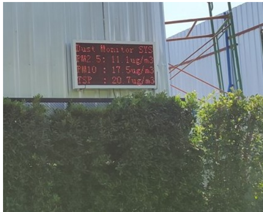
4-24 ติดป้ายแสดงค่าฝุ่นละอองในบรรยากาศแบบ real time ที่รั้วโครงการ
