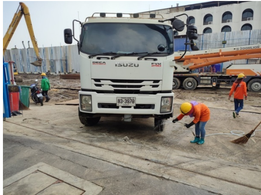
4-12 ล้างล้อรถบรรทุกด้วยสายฉีดน้ำแรงดันสูง ฉีดล้างเศษดินบริเวณทางเข้า-ออก
