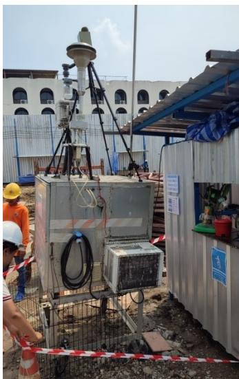
ติดตั้งเครื่องตรวจวัดฝุ่นละออง แบบ Gravimetric method ก้าวชมลพิษภายในพื้นที่โครงการ CO , NO 2 , SO 2 , THC เครื่องตรวจวัดเสียง และเครื่องวัดแรงสั่นสะเทือน ย้ายไปตามจุดที่มีการทำเสาเข็ม ภายในพื้นที่โครงการ
