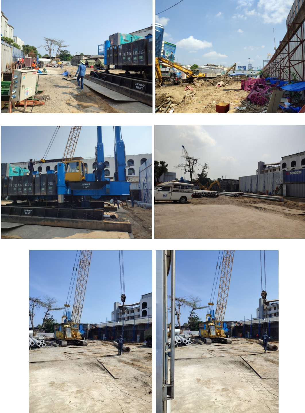
4-8 การดำเนินการช่วงทำเสาเข็มแบบกดไฮโดรลิก
