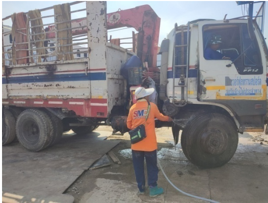
4-12 ล้างล้อรถบรรทุกด้วยสายฉีดน้ำแรงดันสูง ฉีดล้างเศษดินบริเวณทางเข้า-ออก
